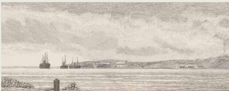
Figure 4. L'hôpital Caroline, réceptionné le 30 juin 1824 (construit par Michel-Robert Penchaud sur l'île de Ratonneau) puis transformé en un grand lazaret (de 1851 à 1887) pour remplacer le lazaret d'Arenc. Vue depuis le port Dieudonné. Le Monde illustré, n° 2081, 13 février 1897. (Coll. Guy Dutau.)
